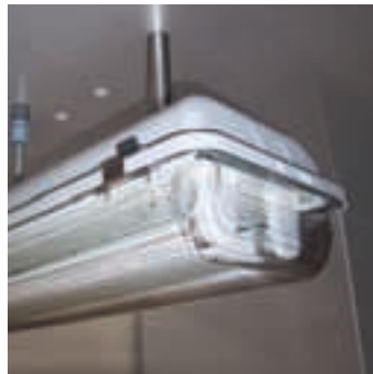
Leuchtstofflampe zur besseren Reinigungsmöglichkeit auf Abstand montiert.
