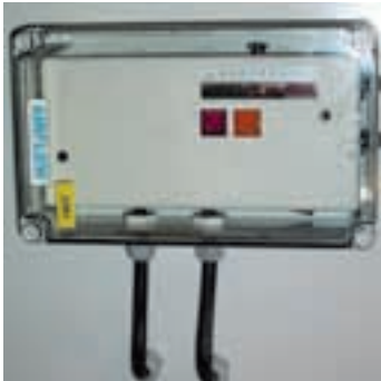
Filterüberwachung mit elektrischem Schaltkontakt Schutzart IP65.
