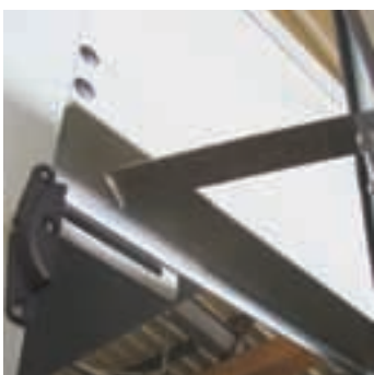
Fangvorrichtung bei druckseitigen Türen erhöhen die Sicherheit.
