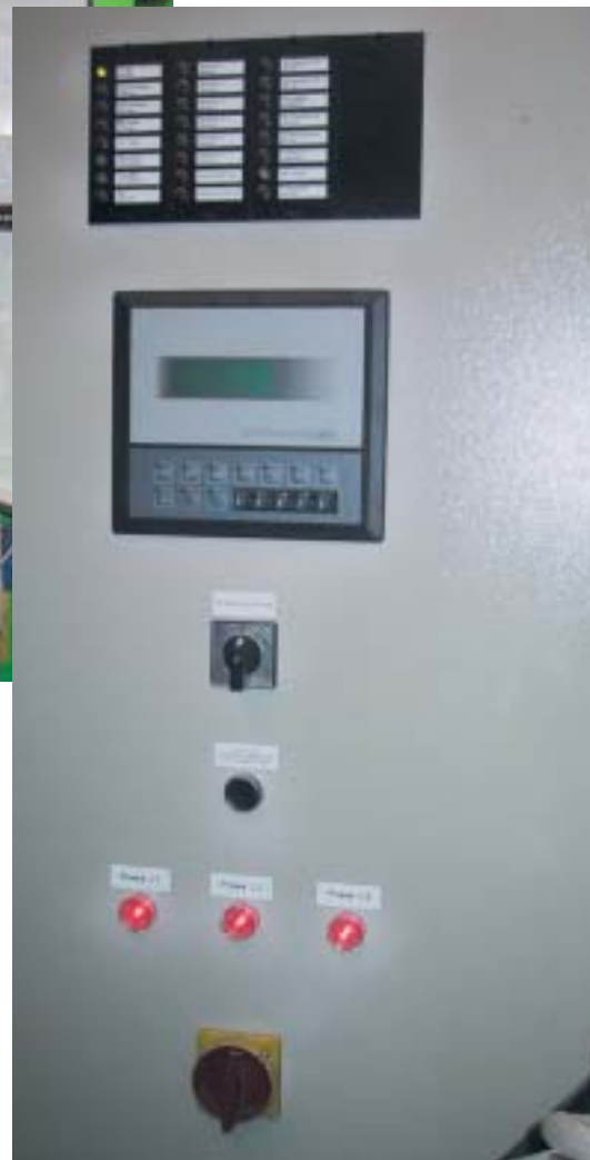
Die Schalttafel wird vom Luftstrom getrennt in die Gerätefront eingelassen. Die Bedien- und Anzeigeelemente werden in die Gerätetür eingebaut.
