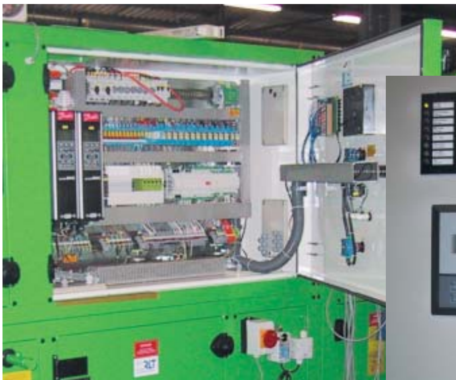
Die Schalttafel wird vom Luftstrom getrennt in die Gerätefront eingelassen. Die Bedien- und Anzeigeelemente werden in die Gerätetür eingebaut.
