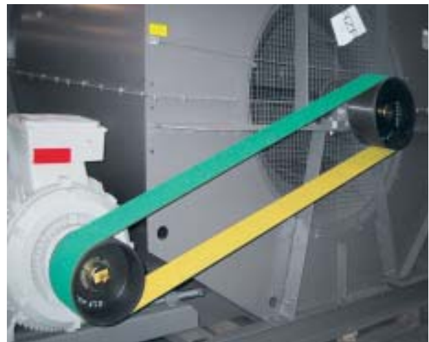
Energiesparender Flachriemenantrieb
