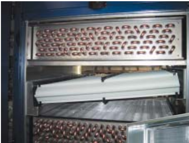
Schräger Tropfenabscheider für vertikale Luftführung von oben nach unten.
