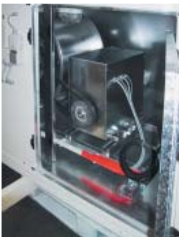
Doppelmotor für erhöhte Betriebssicherheit.
