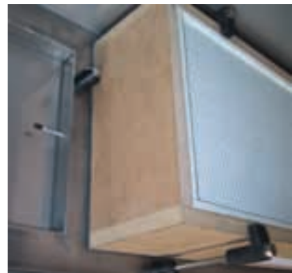
Filtereinbau mit Dichtsitzprüfung bei Typ LCS
