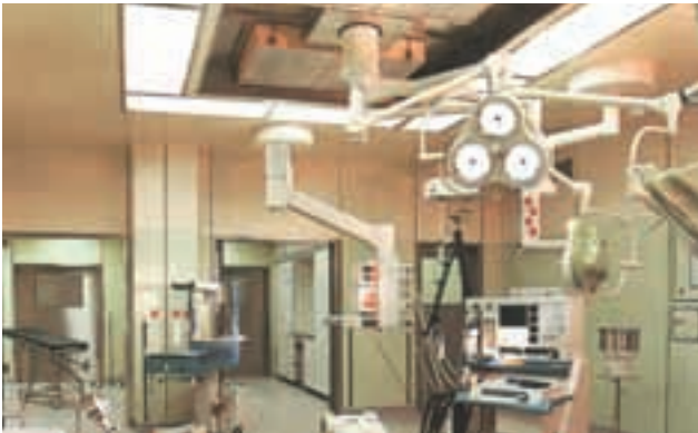
OP-Decke bei demontiertem Laminarisator
