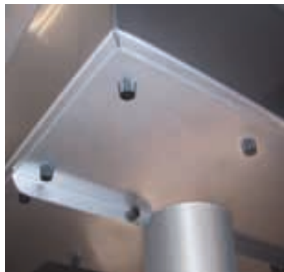
Lampenschacht mit geteilter Wartungsplatte
