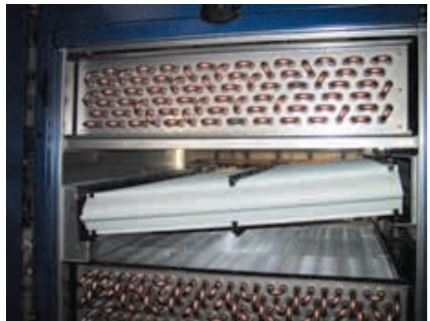
Schräger Tropfenabscheider für vertikale Luftführung von oben nach unten.
