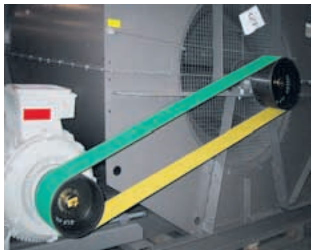
Energiesparender Flachriemenantrieb
