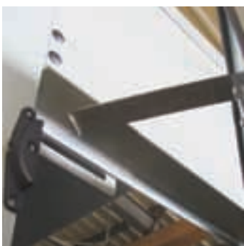
Fangvorrichtung bei druckseitigen Türen erhöhen die Sicherheit.
